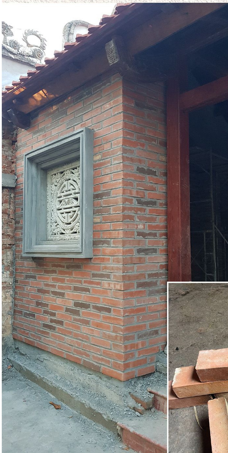
Gạch Đinh Xây Không Trát 220x100x65(mm)
